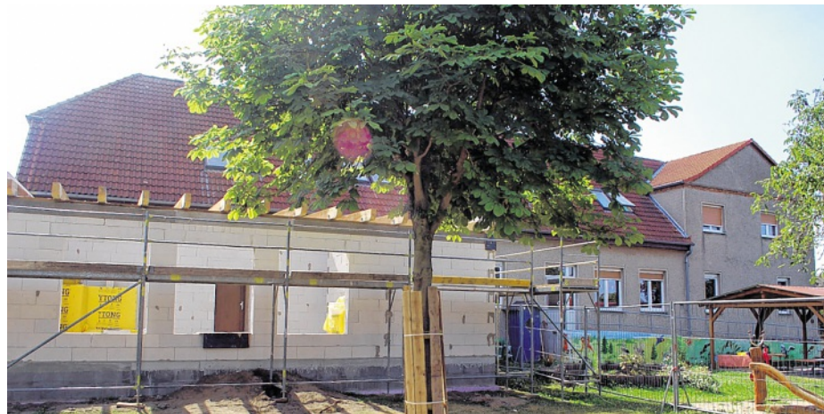
Rund 110 000 Euro kostet der Anbau für die Kleinower Kita.
